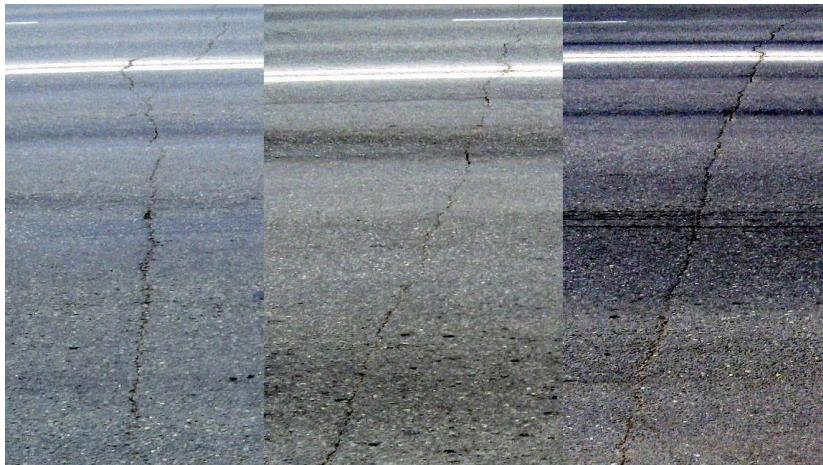
Рис. 1. Трещины разрыва (ул. Кирова, Новосибирск, июль 2016 г.)
